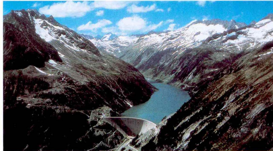
Speicher Zillergründl der Kraftwerksgruppe Zemm/Ziller
